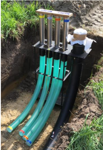
Abbildung 2 Verrohrung bei nicht unterkellertem Gebäude
