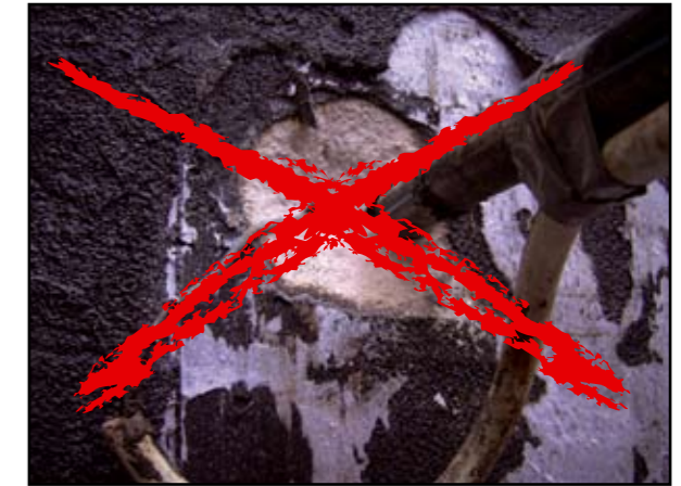
Nicht fachgerechte Einbindung der Gebäudeabdichtung
