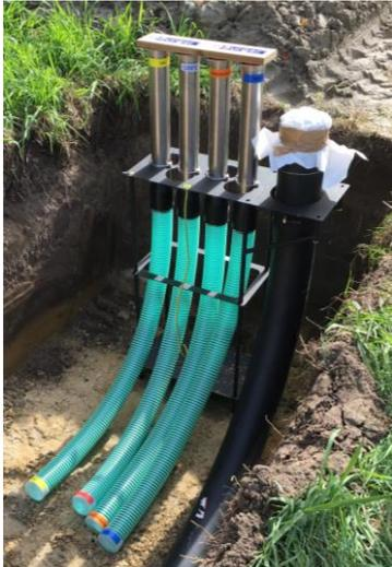
*Abbildung 2 Verrohrung bei nicht unterkellertem Gebäude*
