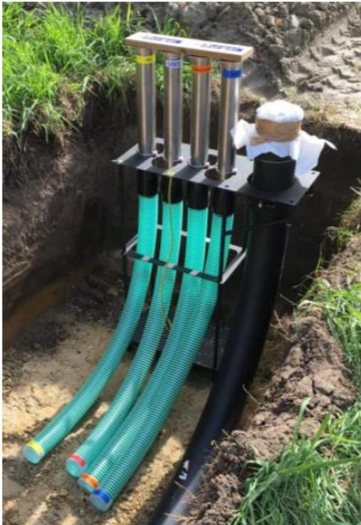
Abbildung 2 Verrohrung bei nicht unterkellertem Gebäude
