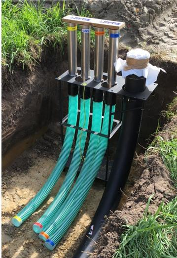
Abbildung 2 Verrohrung bei nicht unterkellertem Gebäude
